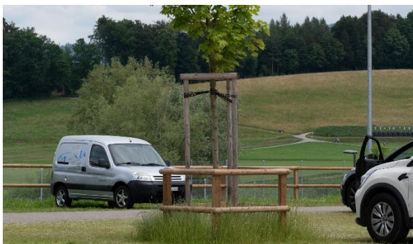
Wasserdurchlässige Parkfläche mit Gehölzen als Schattenspender
